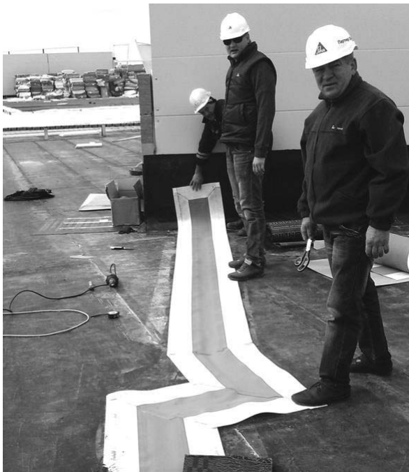
Рисунок 10. Эксплуатируемая кровля, Киев. Деформационные швы в кровле из битумной мембраны
