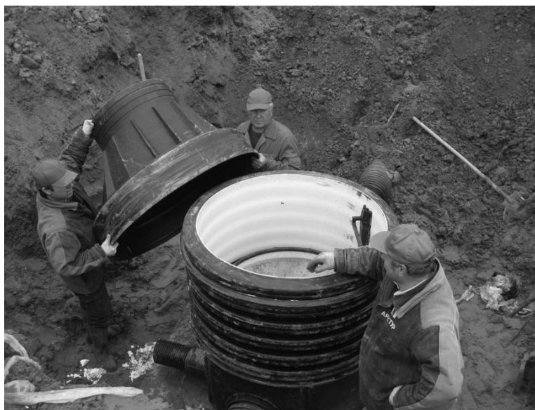
Рисунок 1. Смотровой колодец, выполненный из элементов полиэтиленовой трубы
