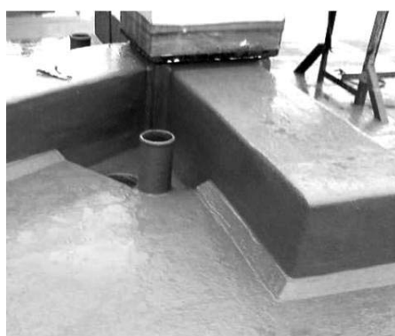
Рисунок 5. Узел с жидкой полиуретановой мембраной
