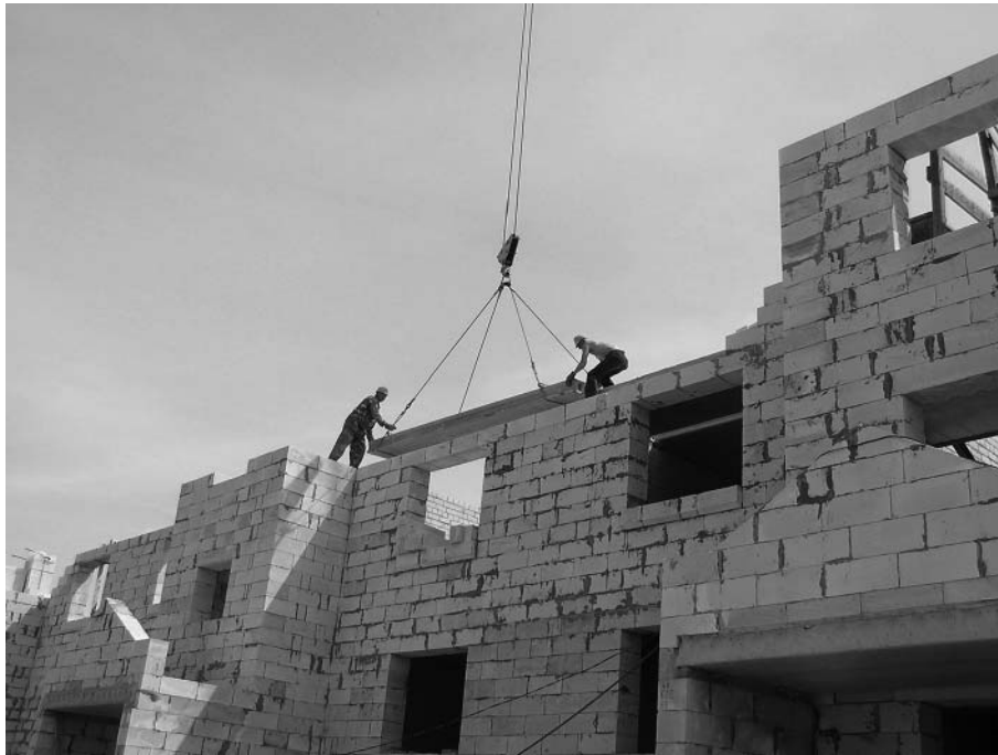
Рисунок 1 – Здание с поперечными несущими стенами из кирпичной кладки
