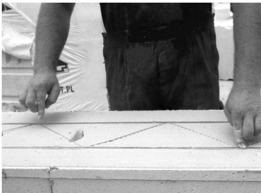
Рисунок 7 - Правильное выполнение укрепления в подоконной зоне.
