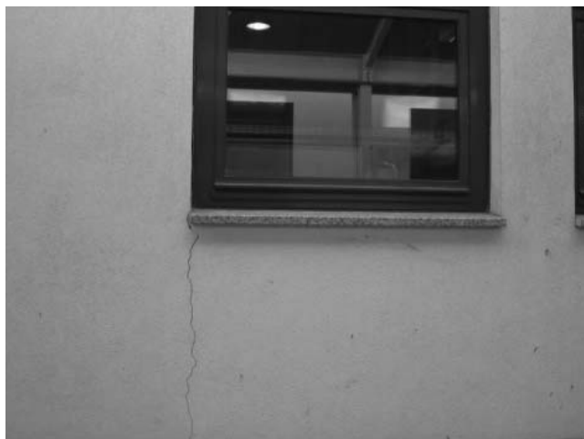
Рисунок 6 -. Трещины на стене, возникшие в результате отсутствия арматуры в подоконной зоне [ 10 ]
