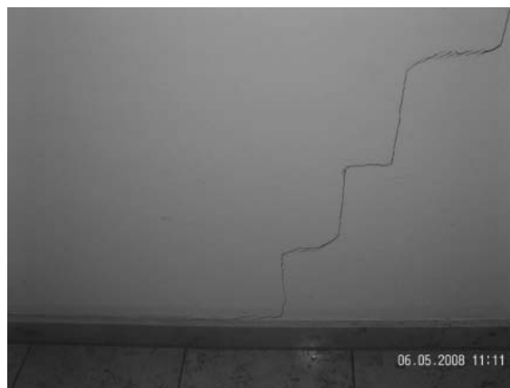
Рисунок 5 - Трещины на стенах, возникшие в результате прогиба перекрытия [ 10 ]
