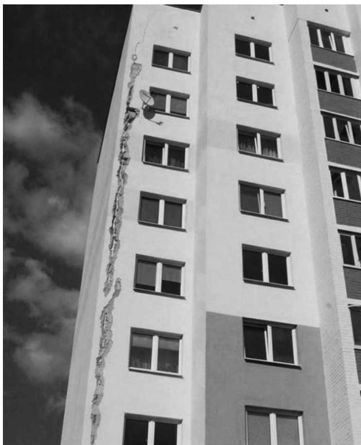
Рисунок 4 – Трещинообразование между самонесущим слоем из ячеистобетонных блоков и несущей кирпичной стеной в процессе эксплуатации 9-этажного жилого дома
