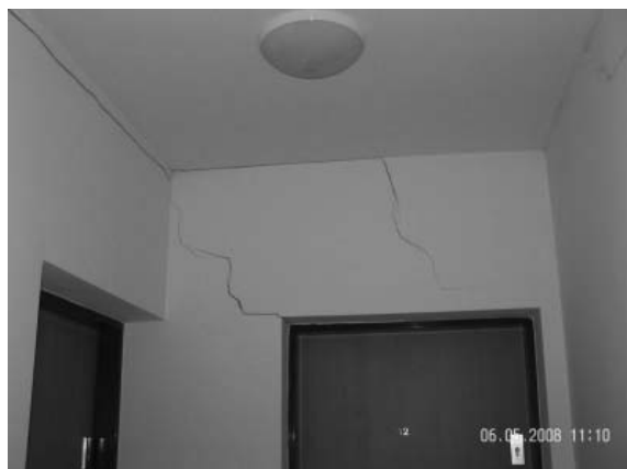
Рисунок 5 - Трещины на стенах, возникшие в результате прогиба перекрытия [ 10 ]
