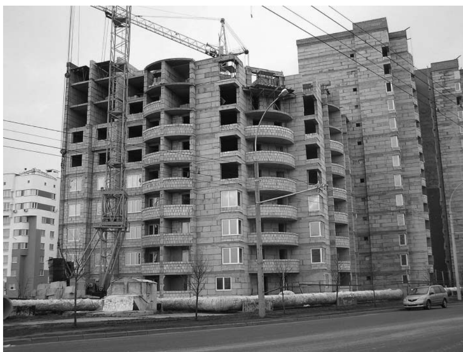
Рисунок 3 – Жилой дом с поперечными несущими стенами из бетонных блоков типа ФБС в процессе строительства
