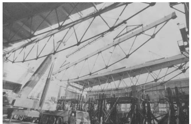
Рис. 3. Металодерев'яна ферма прольотом 53 м
