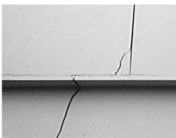
Фото. 1. Характерные дефекты в гипсокартонных конструкциях
