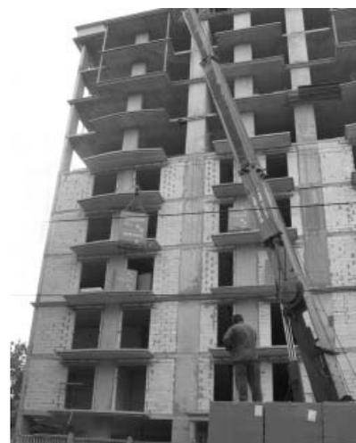
Рис. 5. Применение газобетонных блоков AEROC в многоэтажном строительстве
