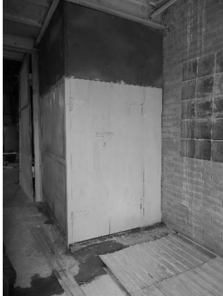
Рисунок 4. Внешний вид металлоконструкций шахты грузового лифта после нанесения слоев грунтовочного (а) и атмосферостойкого геоцементного покрытия (б)
