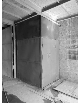
Рисунок 4. Внешний вид металлоконструкций шахты грузового лифта после нанесения слоев грунтовочного (а) и атмосферостойкого геоцементного покрытия (б)
